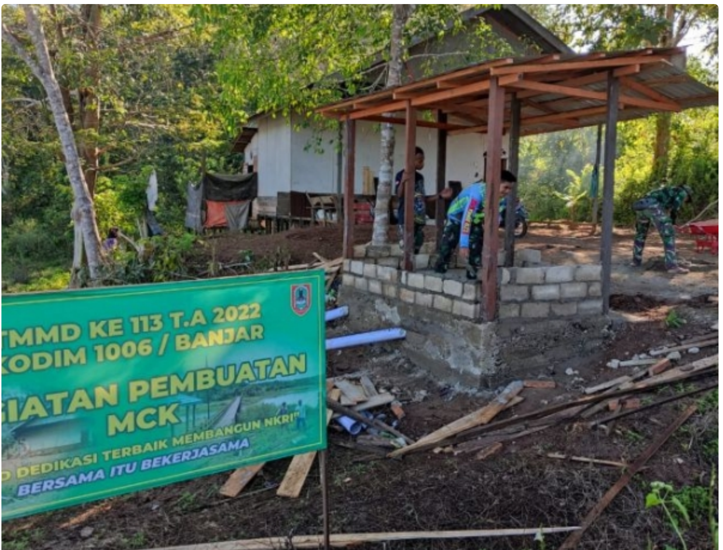
Sasaran WC Terus dikerjakan Satgas TMMD ke-113 Kodim 1006/Banjar
