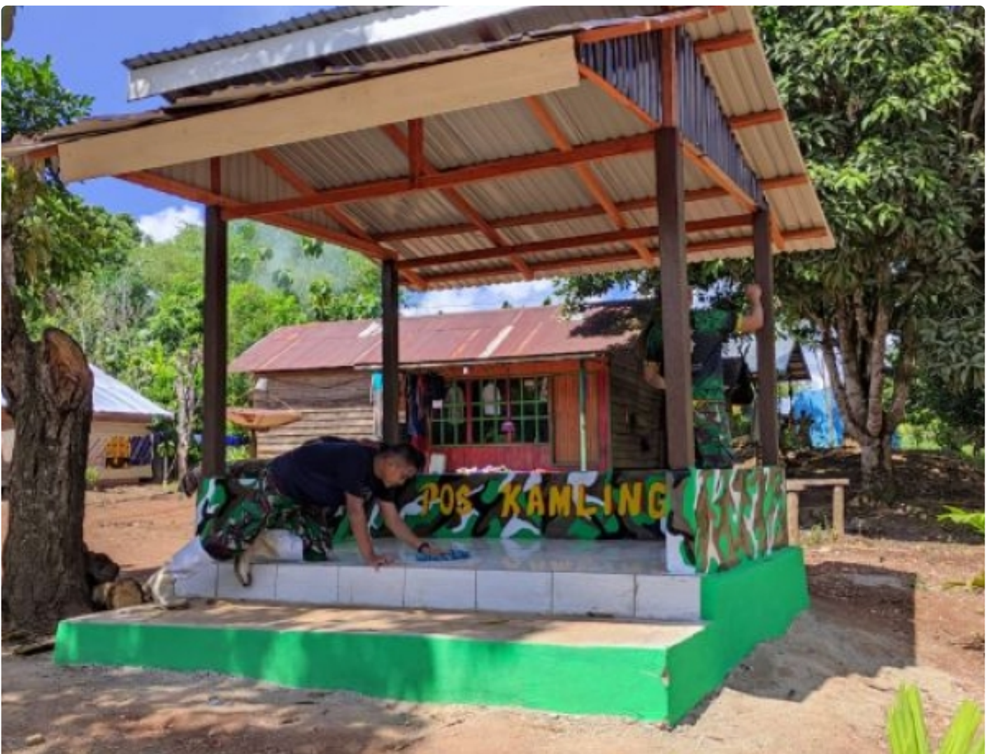
Anggota Satgas TMMMD ke-113 Kodim 1006/Banjar Finshing Pembangunan Pos Kampling
