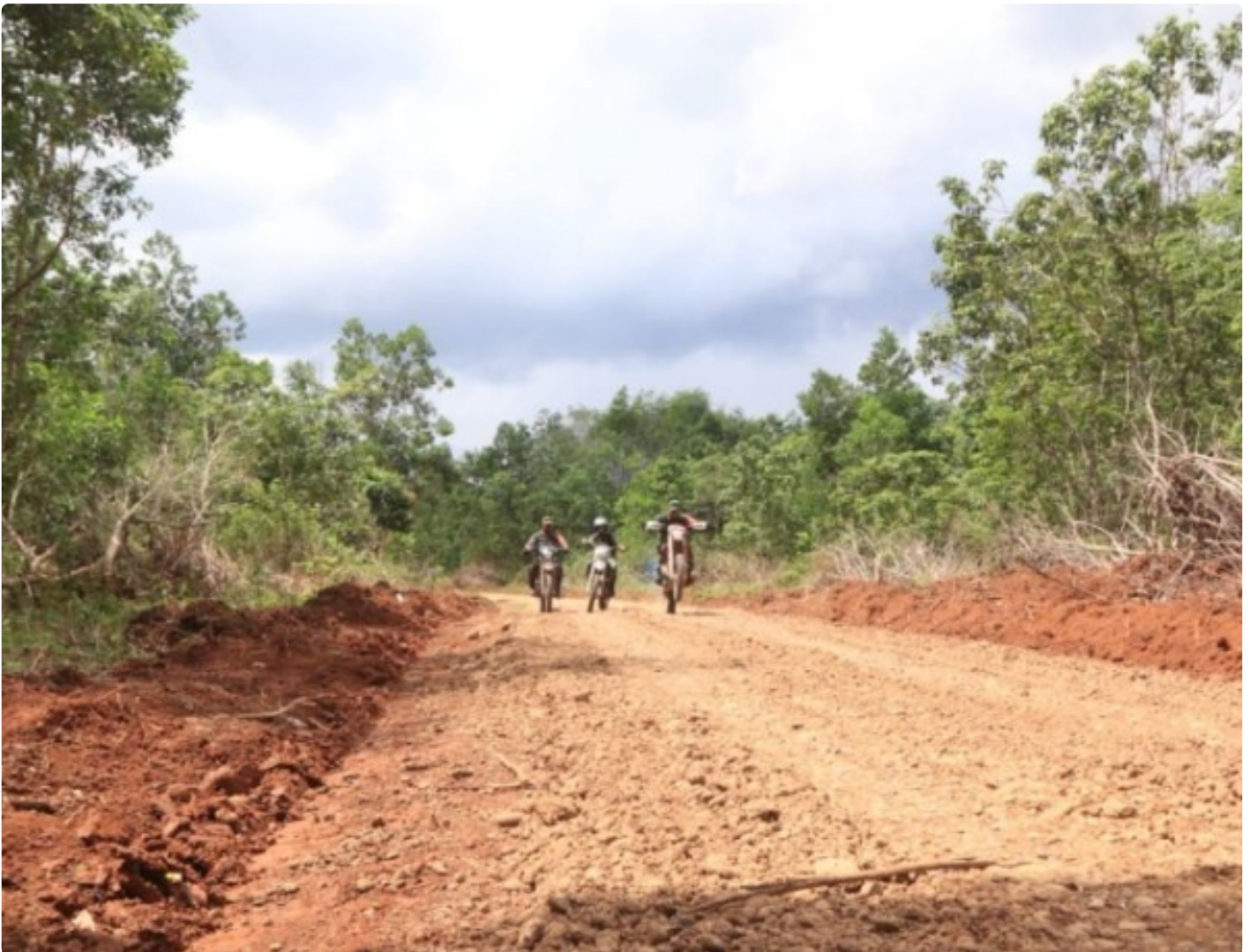
Sasaran Jalan TMMD ke-113 Kodim 1006/Banjar
