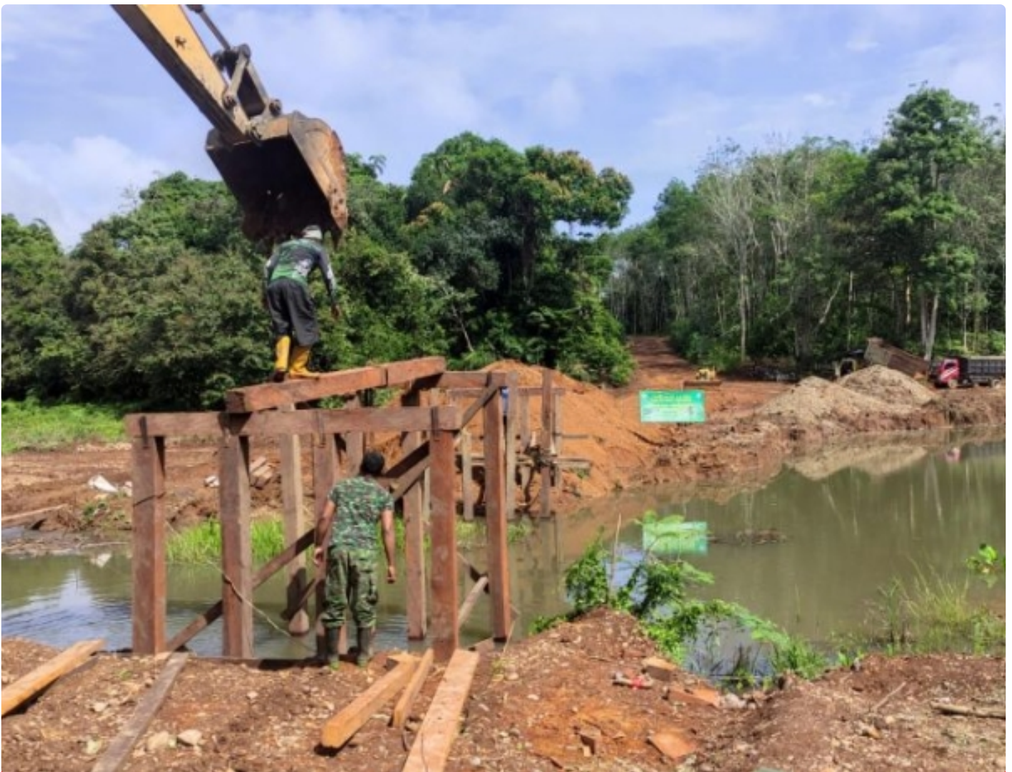
Sasaran Jembatan Terus Dikebut oleh Satgas TMMD ke-113 Kodim 1006/Banjar
