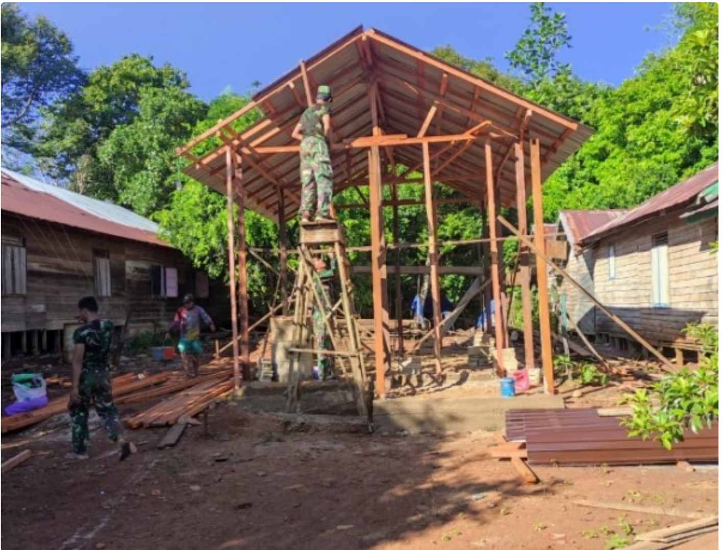
Satgas TMMD ke-113 Melanjutkan pembangunan rumah Nenek Marawiyah
